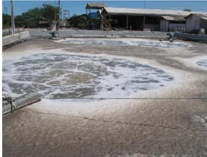
Figura 4. Curtume: Tanque de resíduos líquidos e sólidos para passarem pelo processo de decantação
