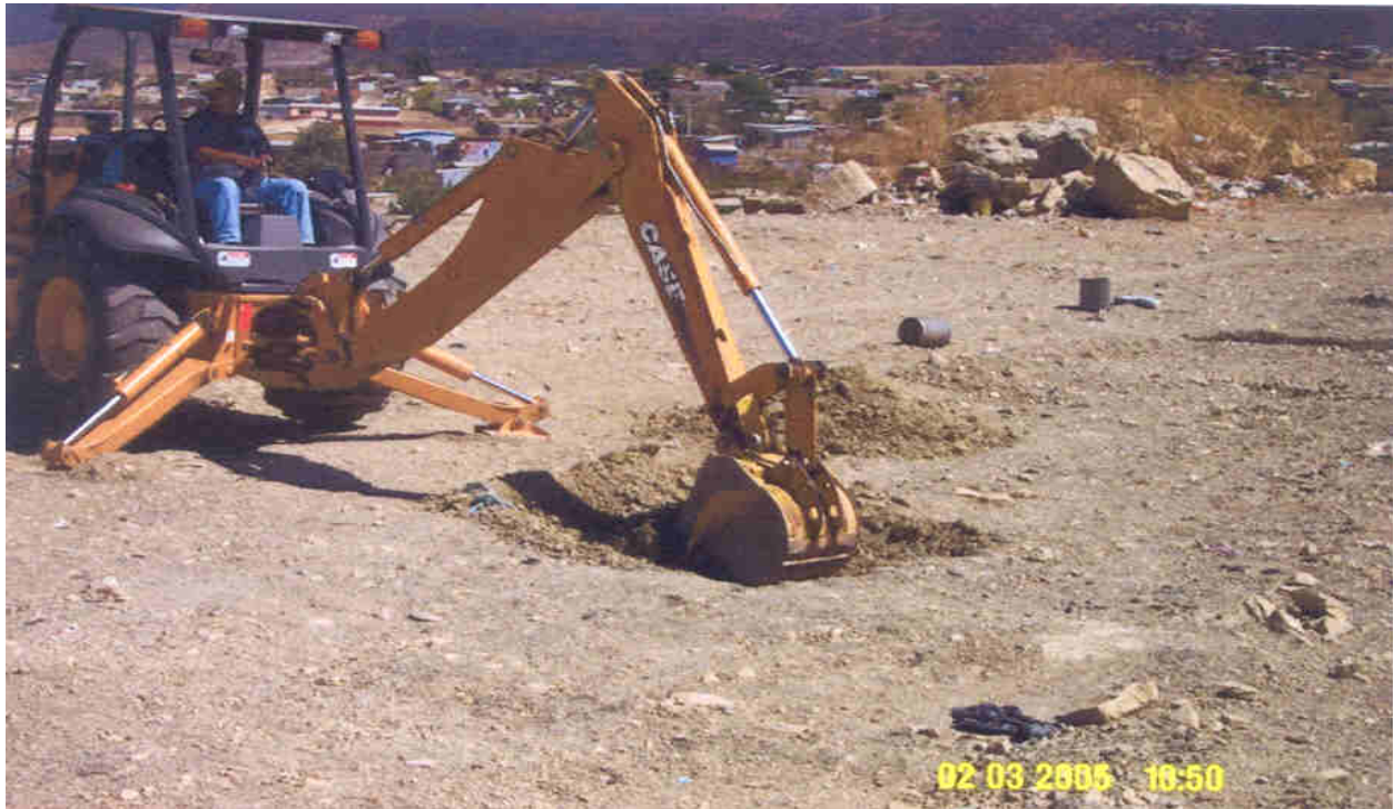
Figura 4.- Excavación de pozo a cielo abierto para tomar una muestra alterada.
