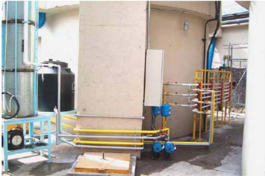
Figura 1. Esquema y fotografía del sistema Biorreactor Anaerobio de Membrana
