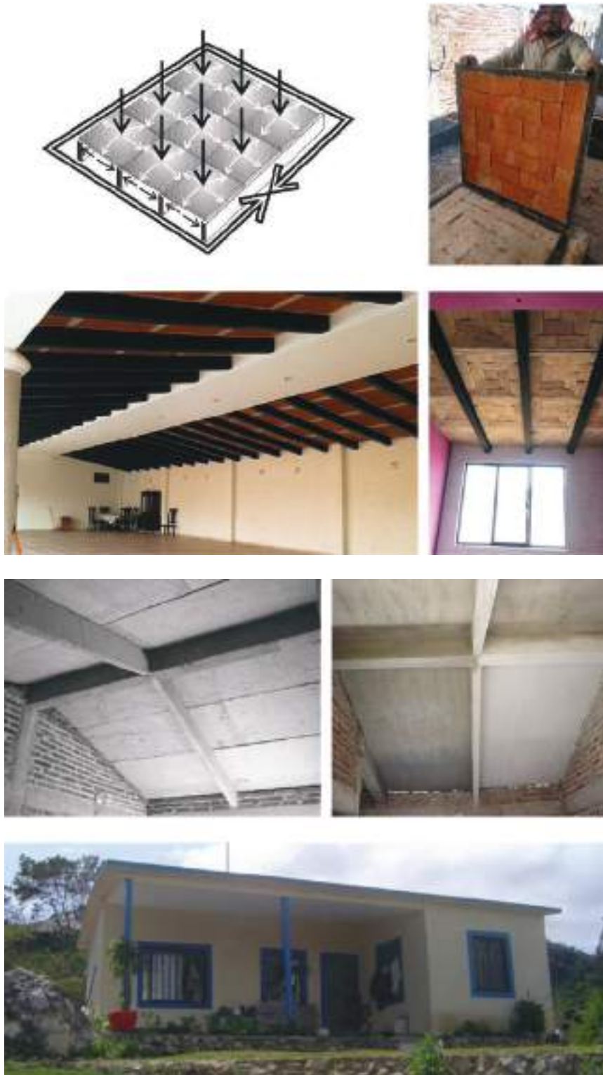
Figura 4. Techo prefabricado Domotej, desarrollo tecnológico de Gabriel Castañeda Nolasco, 2008.
