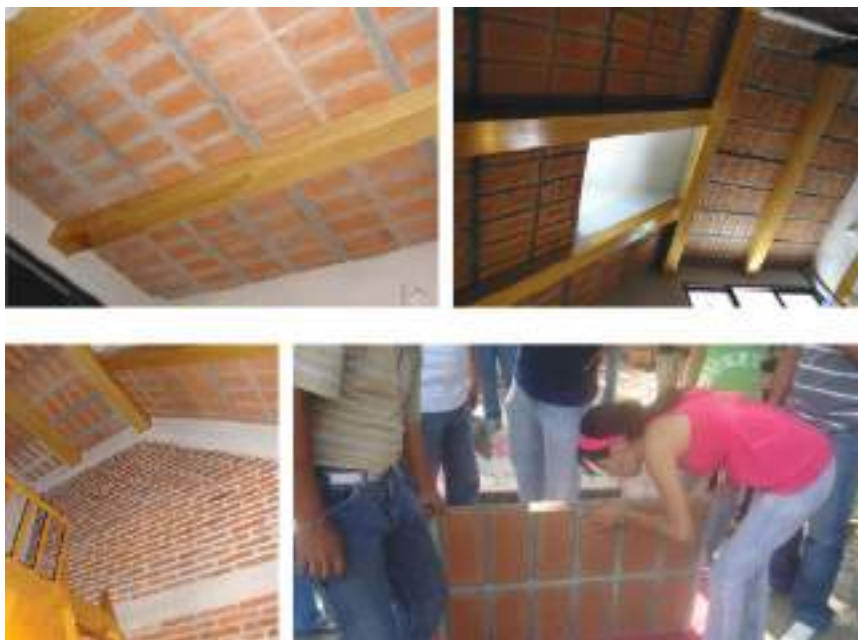
Figura 6. Techo prefabricado Termolosa con acabado aparente integrado (petatillo), desarrollo tecnológico de Gabriel Castañeda Nolasco, 2010.
