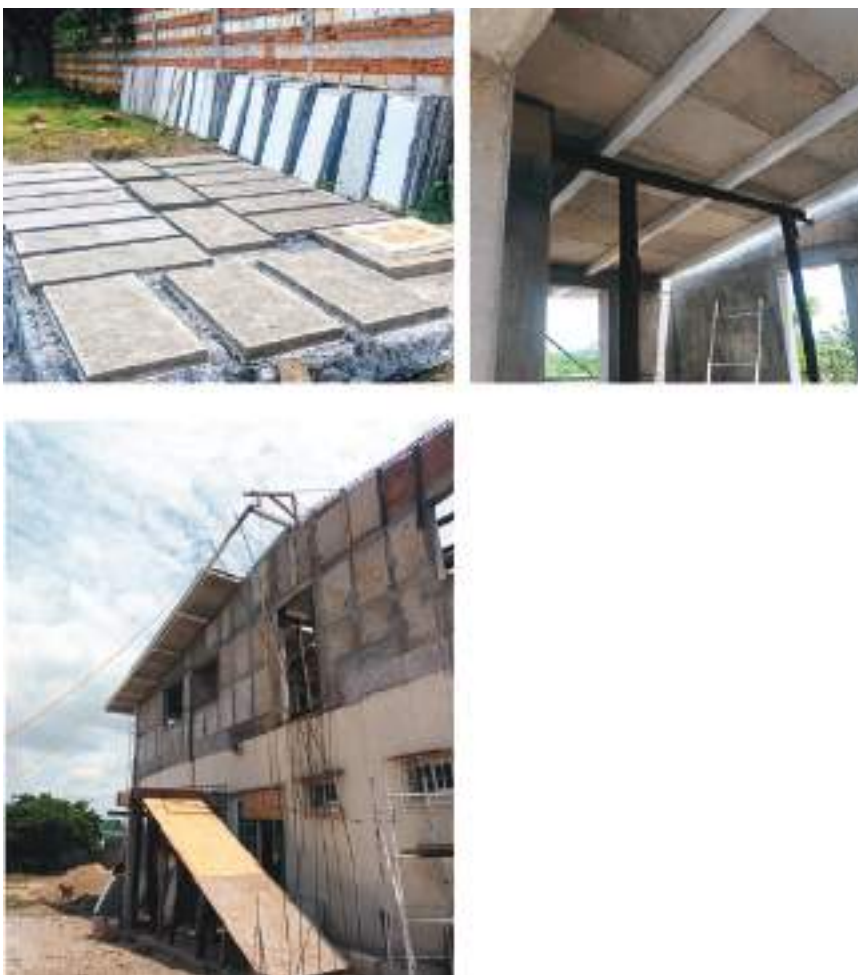
Figura 7. Techo prefabricado Termolosa, desarrollo tecnológico de Gabriel Castañeda Nolasco, 2024.
