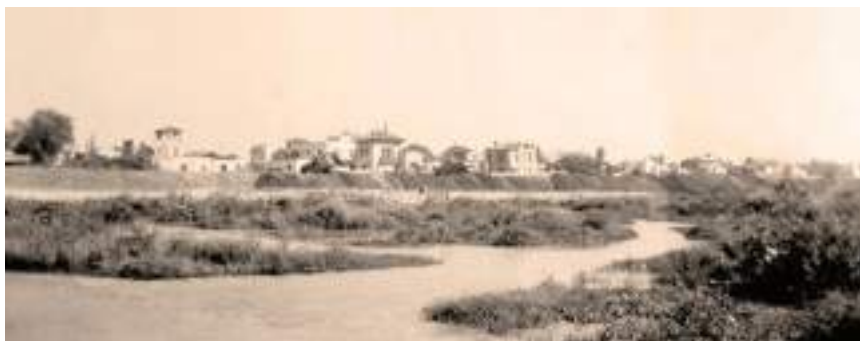
Figura 5. Vista parcial del río Santa Catarina antes de su canalización.
