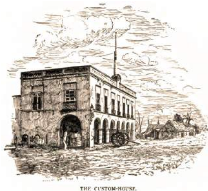
Figura 3. Litografía del edificio de la aduana marítima, 1871.
