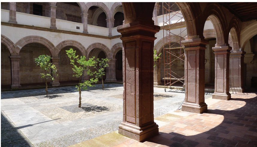
Figura 2. Restauración del claustro del antiguo convento, 2011.
