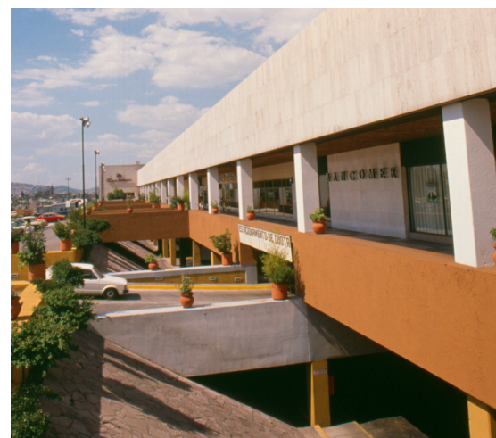
Plaza Satélite (1970-1971), fachada principal con las rampas del estacionamiento subterráneo y puentes para el acceso del peatón hacia el interior del conjunto. Fotografía de los años setenta, Archivo Sordo Madaleno Arquitectos.
