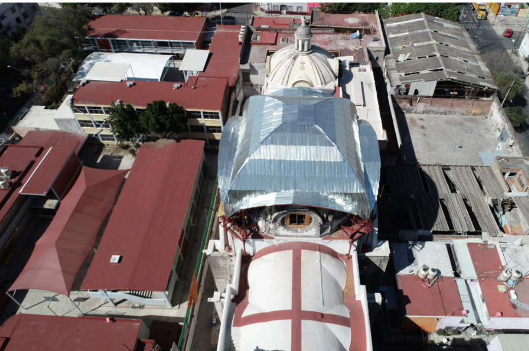
Cuando sea el momento de reconstruir la linternilla, se podrán liberar los plementos regulares contiguos a la zona de la clave polar, sin alterar la estabilidad de la cubierta que trabaja a esfuerzos de compresión. Fotografía: EDTE y RESC.
