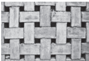
Pavimento de la casa inicial y celosía de los solarium ; detalle. Fotografías: EFC, 2015
