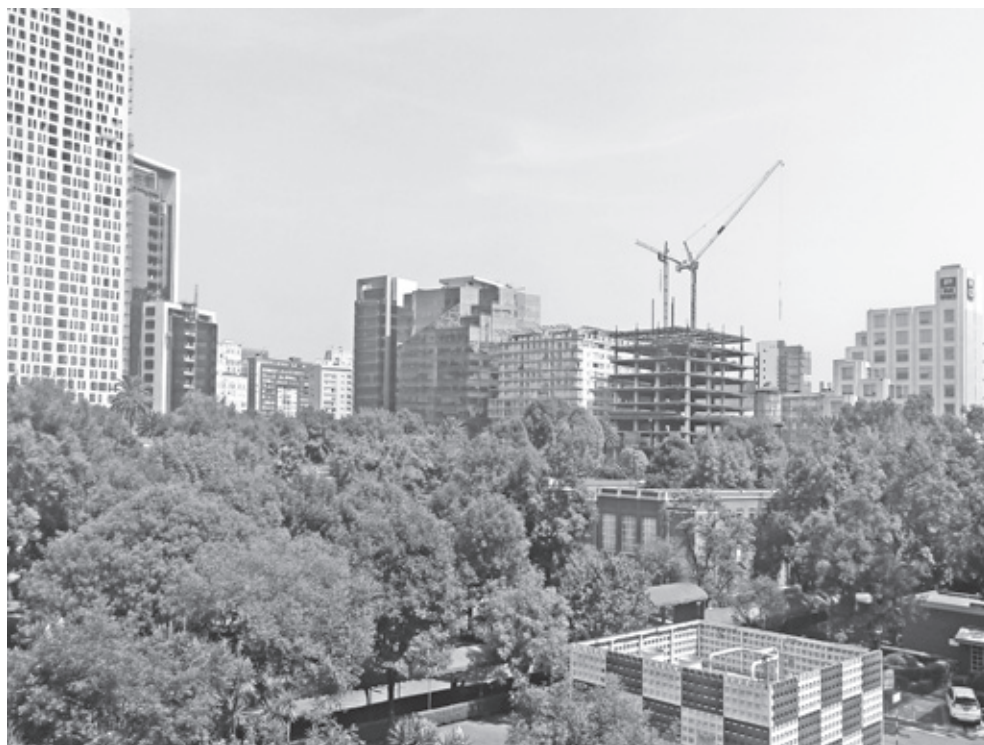
Construcción desbordada de edificios en Nuevo Polanco. APGV
