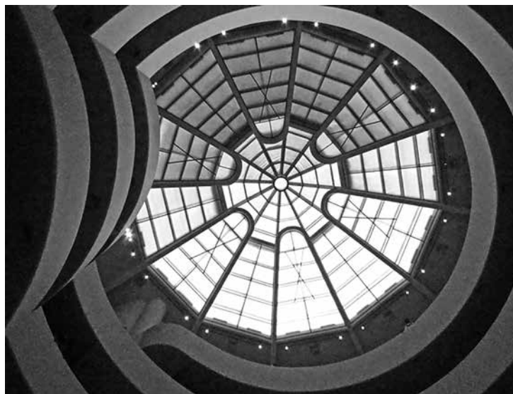
Luz cenital natural en Guggenheim Museum de Nueva York, obra de Frank Lloyd Wright, 1959. Fotografía: JMLP, octubre de 2012
