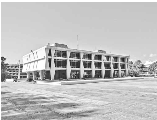
Edificio de Rectoría en la Universidad de San Carlos de Guatemala, obra de Raúl Minondo, Carlos Haeusseler, Jorge Montes y Roberto Aycinena 1960. Fotografía: JMLP, abril 2014
