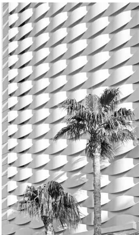
Doble fachada ventilada con funciones decorativas y de protección solar. Hotel Boutique & Spa , Sitges, España.
