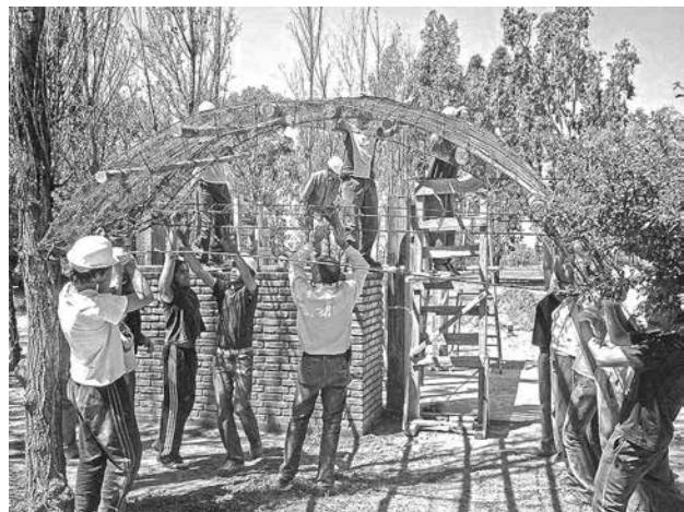
Izquierda, croquis del crecimiento progresivo de la vivienda. Derecha, izado de la estructura, (CGL)
