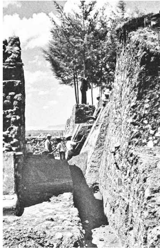
Excavación en el montículo I de Kaminaljuyu. Fotograma del noticiero filmico Actualidades Guatemaltecas de marzo de 1937. Digitalización: EB, 2014
