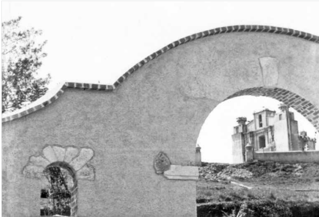
Construcción donada por la Colonia Española residente en Guatemala. Al fondo, la ermita colonial que corona el "cerrito del Carmen". Fotograma del noticiero fílmico Actualidades Guatemaltecas de noviembre de 1933. Digitalización: Edgar Barillas (EB), 2014
