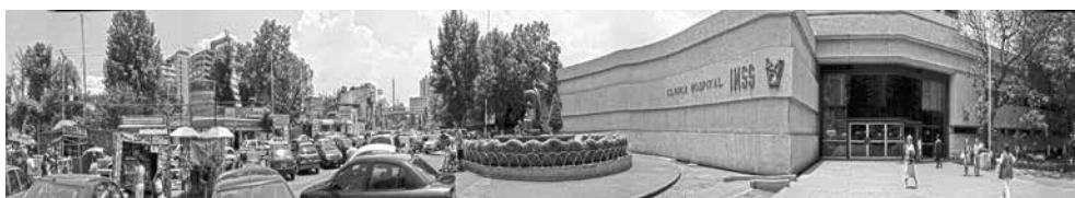
Paneo del exterior de la Clínica (T1). (deformación de origen) Fotografía: JCT, junio de 2007
