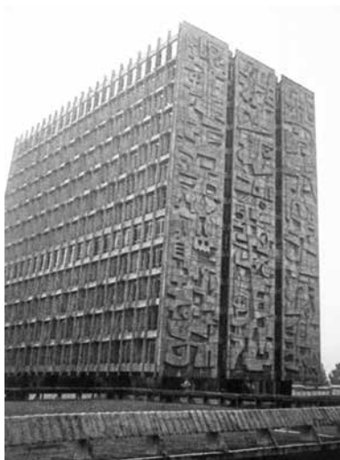
Banco de Guatemala (1966), arquitectos Jorge Montes y Raúl Minondo Fuente: SFP, abril de 2005
