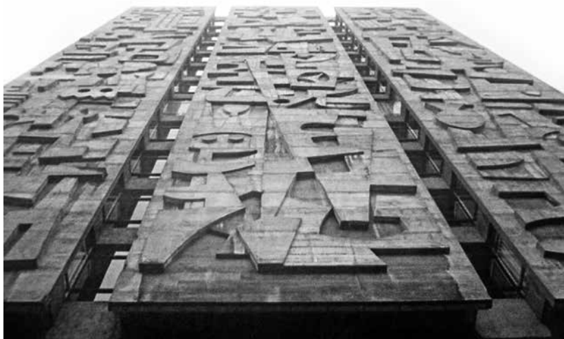
Fachada oeste del Banco de Guatemala (1966). Altorrelieve de Efraín Recinos, con reminiscencias de una estela maya. Fuente: SFP, abril de 2005
