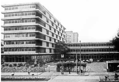
Instituto Guatemalteco de Seguridad Social (IGSS) en el Centro Cívico (1956-1959), arquitectos Roberto Aycinena y Jorge Montes Fuente: SFP, abril de 2005
