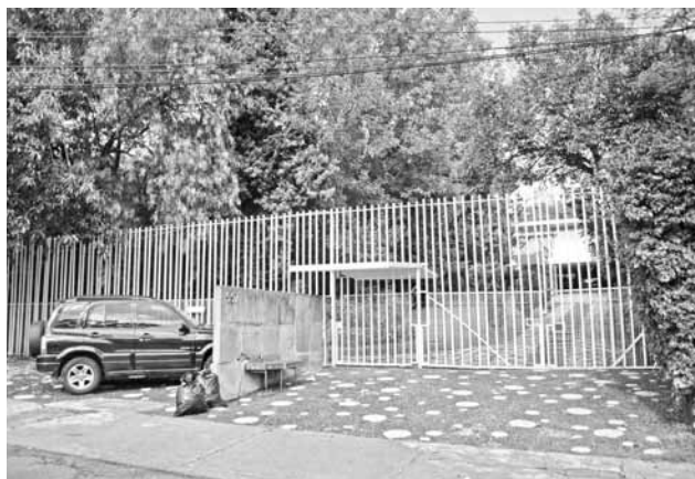
Vista con la barda modificada al hacerla más elevada. Fotografía de Lorena Fainkuchen (2008)
