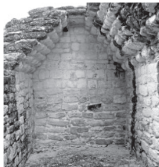
Bóveda escalonada, Becán, Campeche. Foto: (MC), mayo 2012
