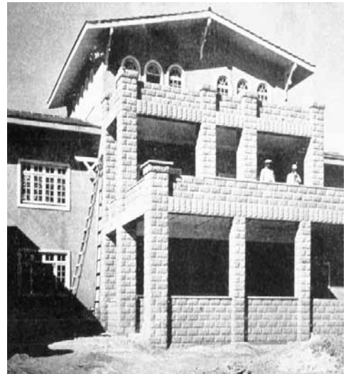
Residencia en Chapultepec Heights , hecha en bloques de concreto, Cemento No. 18, octubre de 1926
