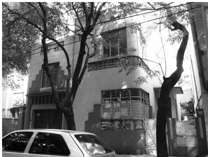
Casa habitación de Francisco J. Serrano, calle Amsterdam 110, Hipódromo Condesa, D. F., 1927-1932.
