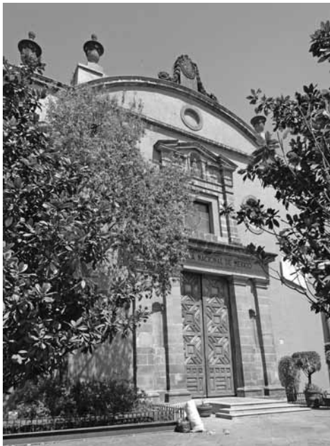
Templo de San Pedro y San Pablo, el cual formaba parte de un extenso conjunto de construcciones jesuitas en el centro de la capital virreinal. Foto: ISMC, 2010
