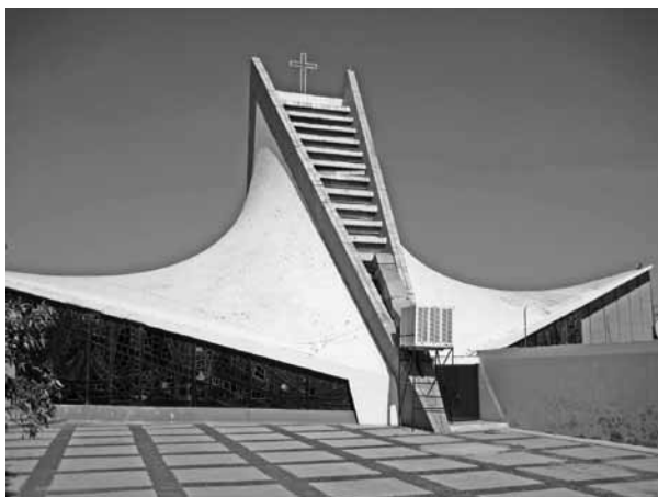
Vista exterior, templo Santa Cruz. Fotografía: JVR
